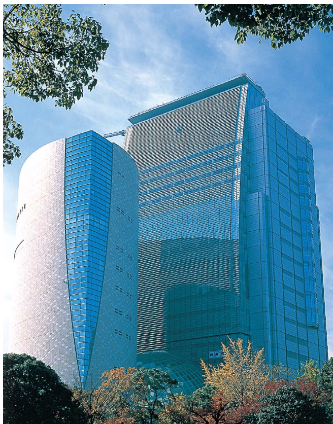
NHK大阪新放送会館、大阪市立博物館、考古資料センター (MSシール・FRシール・耐火目地用シーラント120)
