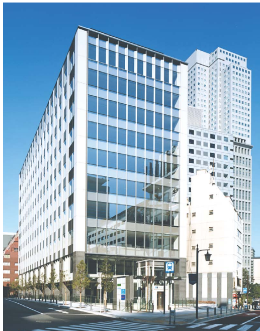
オリックス赤坂2丁目ビル (MSシール・エクシールIB・ビューシール6909・PSシール)
