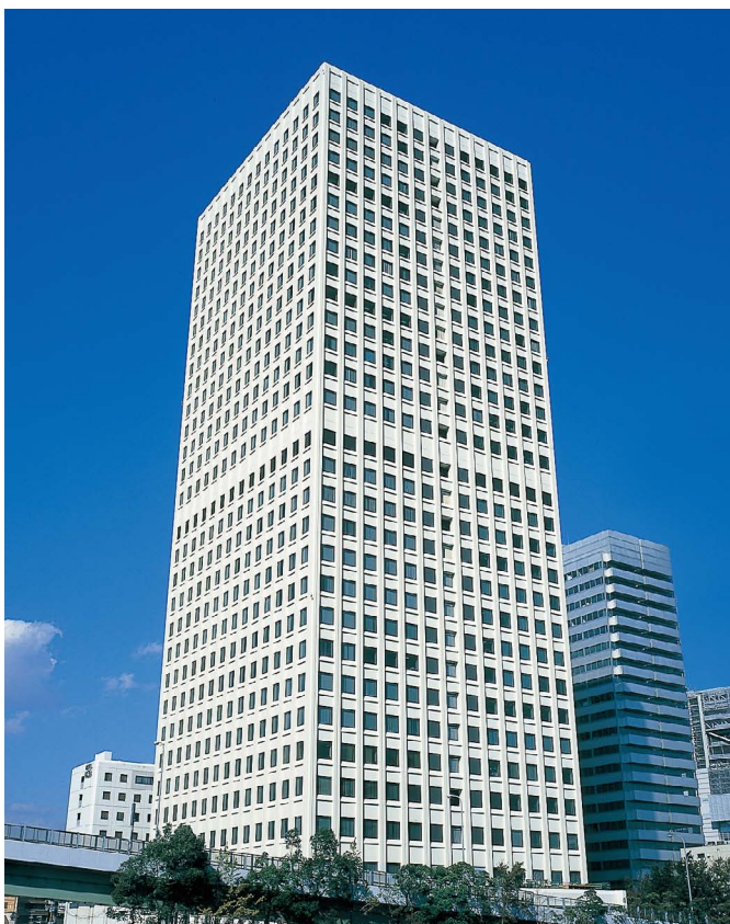
中之島センタービル (改修・AUシール)
