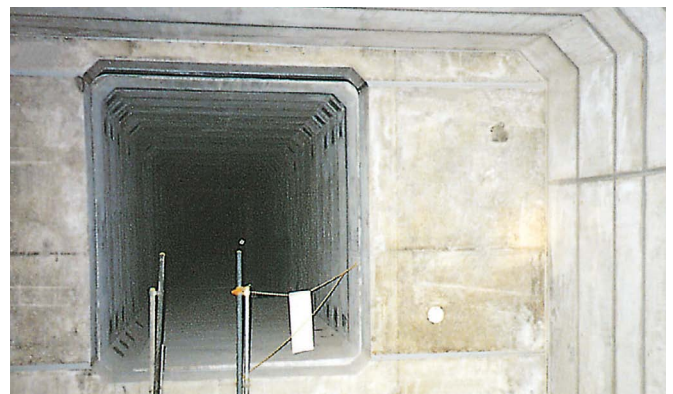
「ボンド UPシール#700」施工物件(共同溝)
