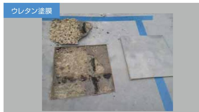
■ウレタン塗膜防水のコンクリート躯体の劣化
